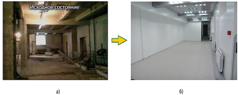
Рис. 3. Производственное помещение (а) до, (б) — после ремонта
